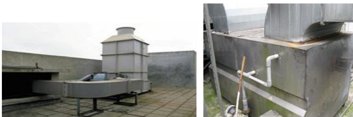
圖 3-5、水洗機示意圖
