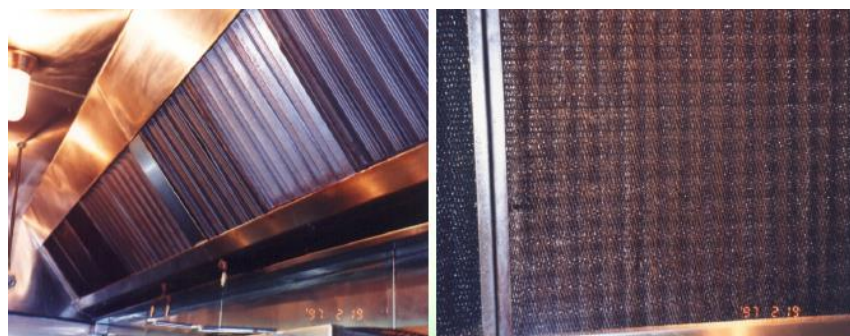
圖 3-2、擋板(左)和濾網(右)示意圖
